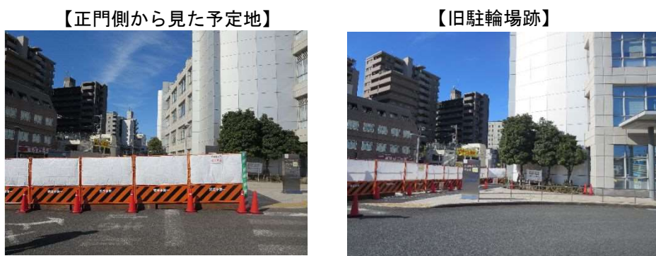
図2：エネルギー棟建設予定地の現況(2月5日現在)
